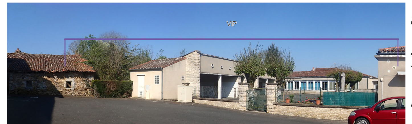
Photo 96 : Depuis la place Capella, le VIP est tronqué par la trame bâtie du village
